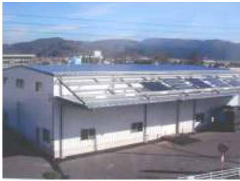
設置状況の写真(看板の写真です。実際にこの角度では見る事が出来ません)
