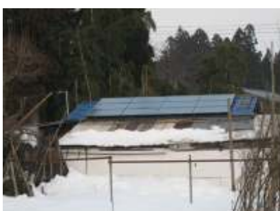
積もった雪を下ろしておいて頂きました。
